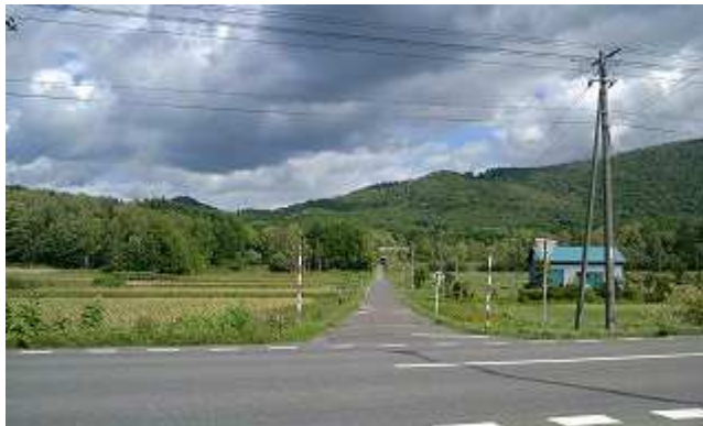
国道40号線から21線踏切方面 (この付近が北緯44度線と国道40号線が交差するところ。)
