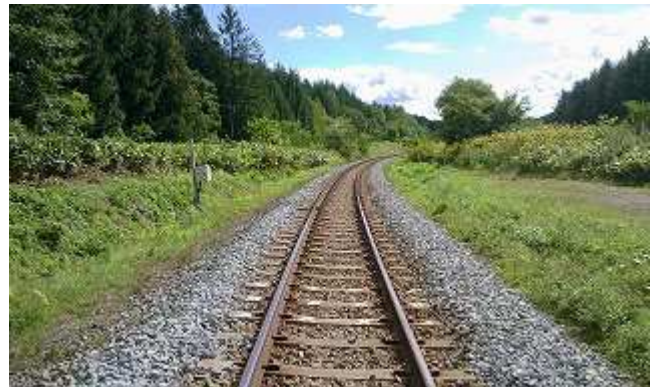
21線踏切より南
