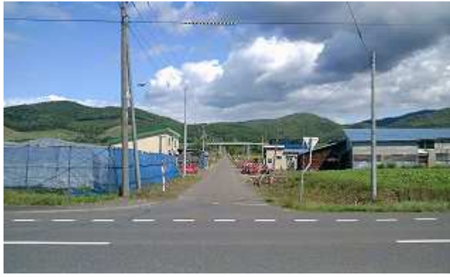
国道40号線から19線踏切方面
