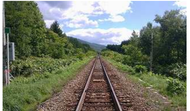
19線踏切より南
